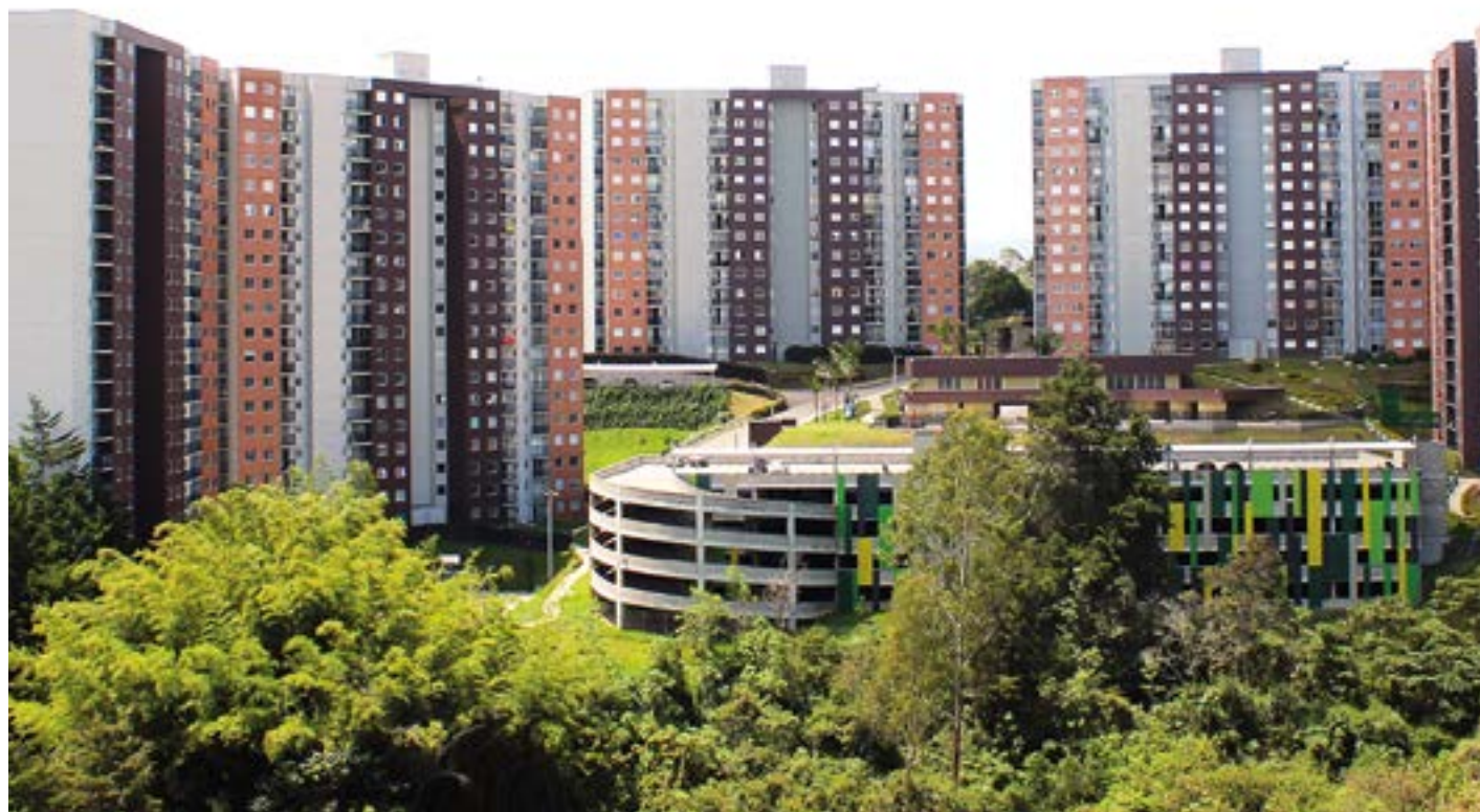
CONTEX CONSTRUCTORA, Proyecto Manzanillos Rionegro Antioquia.
