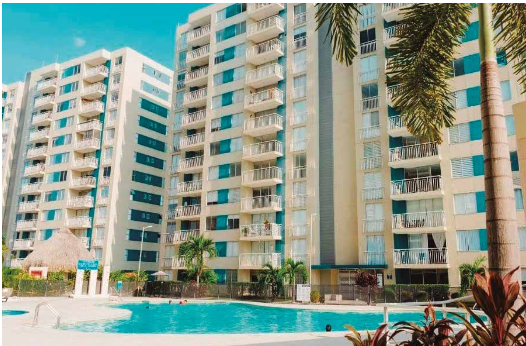
Constructora Conconcreto, Proyecto Puerto Azul, Ricaurte, Cundinamarca.
